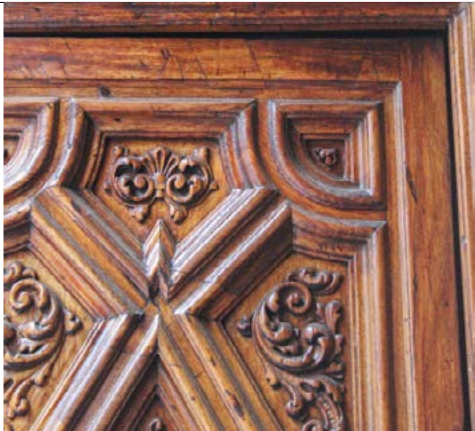
● Injertos de madera reconstruyeron las partes afectadas de la hoja izquierda.
